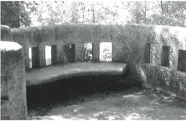
Die „Turm“-Betonbank am Eisenbahnsteg
