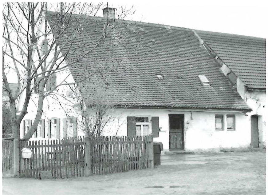
Abb. 3: Am südlichen Stadtrand von Königsbrunn an der alten B 17 ist ein typisches Kolonistenanwesen (Einfirst-Wohnstallhaus) weitgehend im Ursprungszustand erhalten geblieben.
