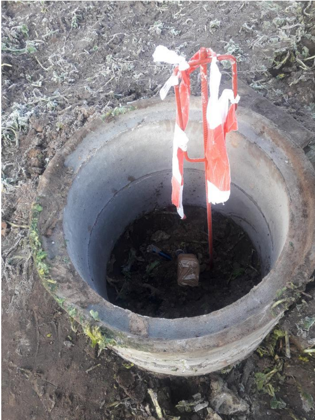
Abb. 2: Erdwärmesonde nach Ende der Testarbeiten
