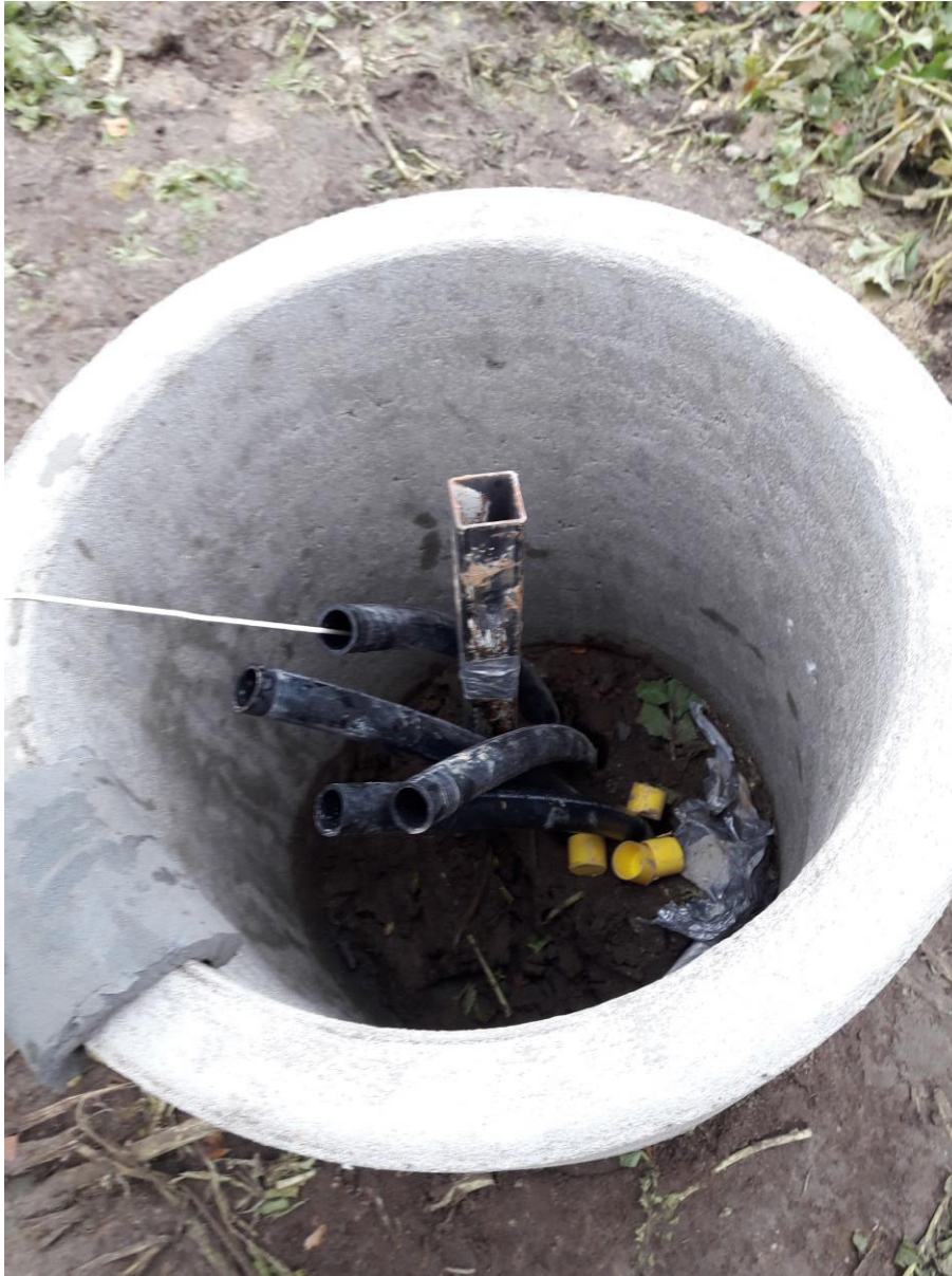
Abb. 3: Erdwärmesonde nach Ende der Testarbeiten
