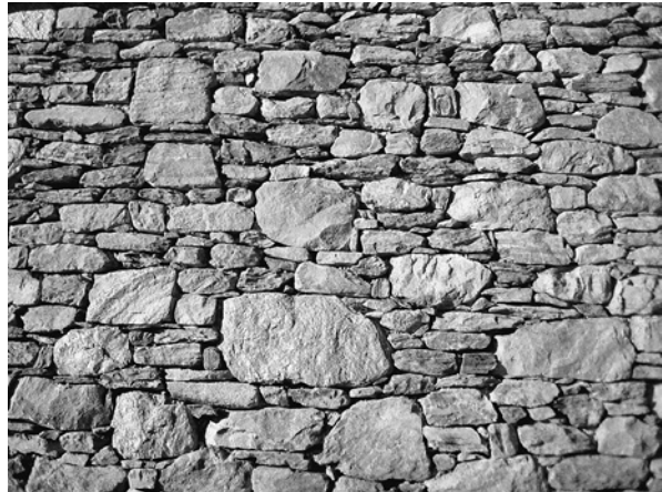
Bild 4: Beispiel Bruchstein-Schichtenmauerwerk
