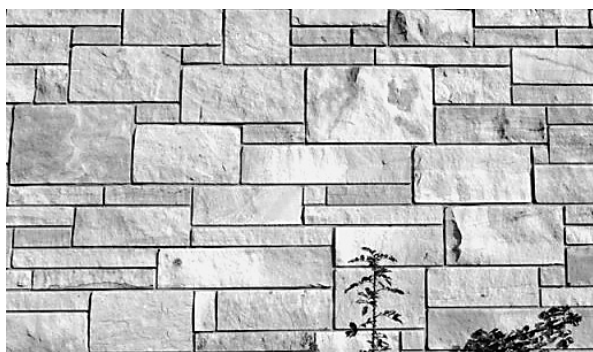
Bild 6: Beispiel Unregelmäßiges Schichtenmauerwerk
