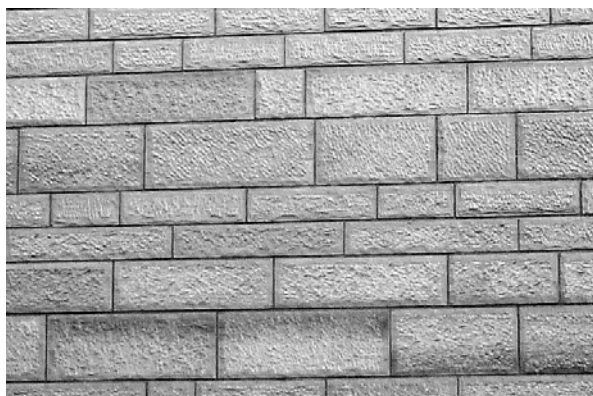
Bild 7: Beispiel Regelmäßiges Schichtenmauerwerk
