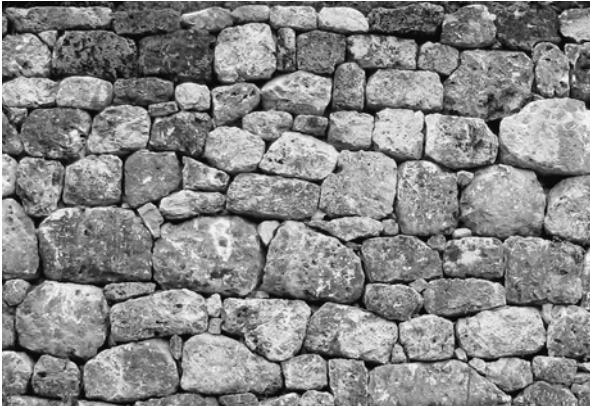
Bild 1: Beispiel Findlingsmauerwerk
