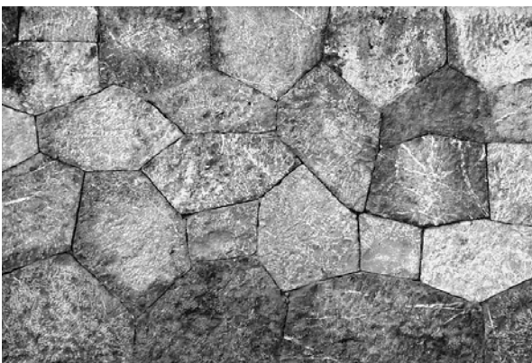
Bild 3: Beispiel Zyklopenmauerwerk
