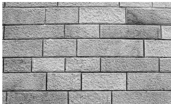
Bild 8: Beispiel Quadermauerwerk
