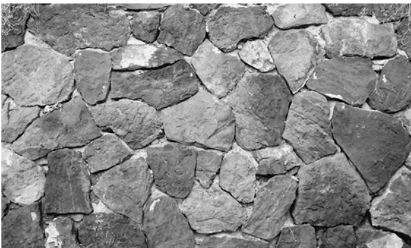
Bild 2: Beispiel Bruchstein-Zyklopenmauerwerk
