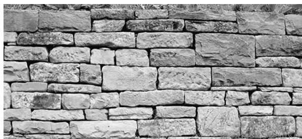
Bild 5: Beispiel Schichtenmauerwerk
