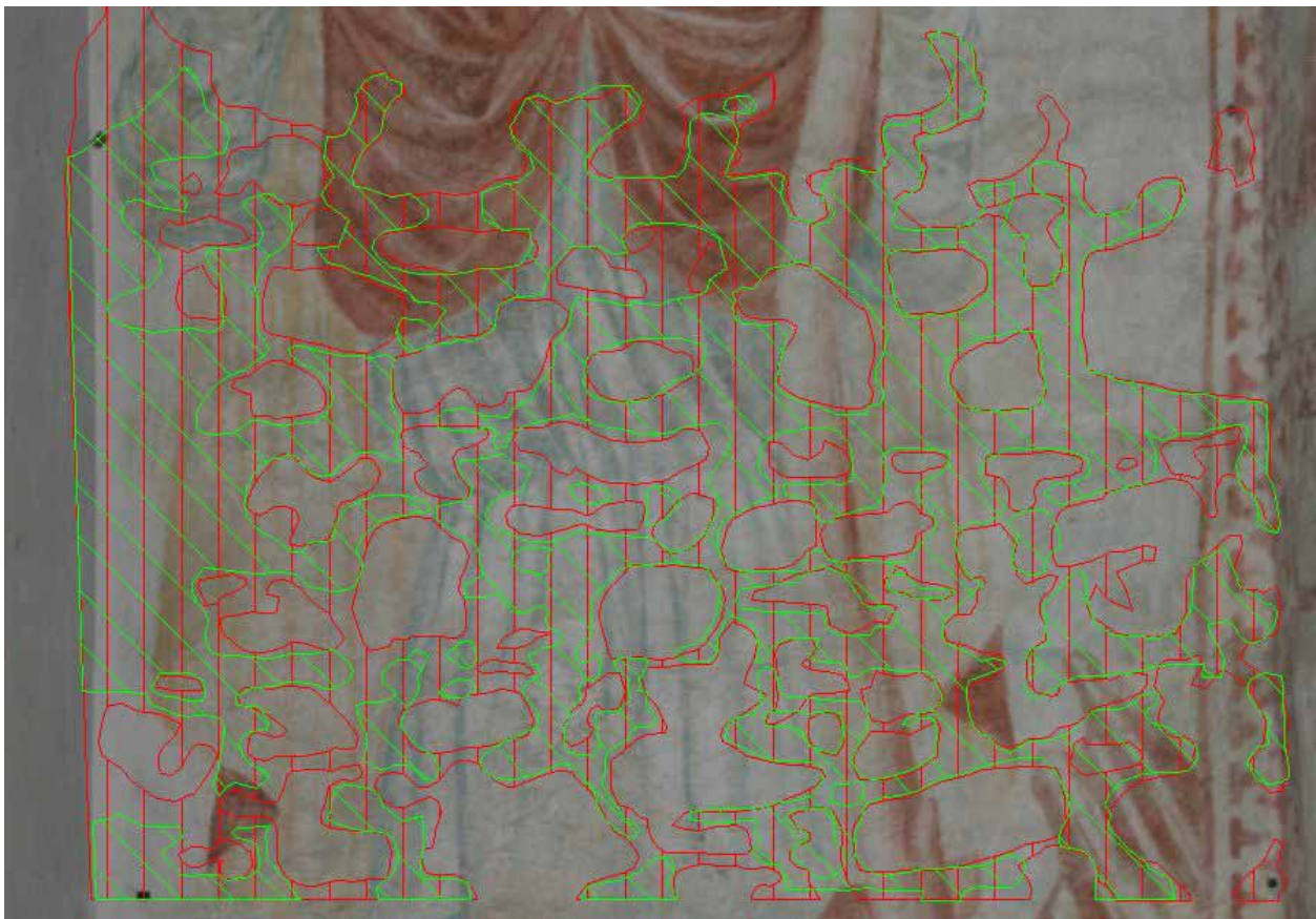
Abb. 178 Rote Schraffur (entfestigte Bereiche) und grüne Schraffur (Hohlstellen) aus der Interpretation unterschiedlicher IR-Sequenzen zusammen in einer Kartierung auf der Grundlage eines Fotos dargestellt (mittlerer Bereich)
