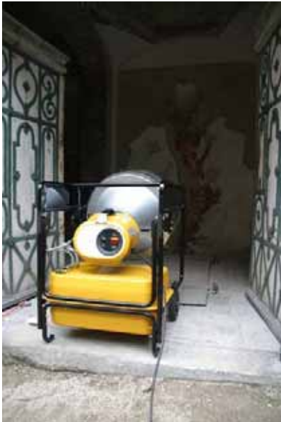
Abb. 9 Görlitz, Nikolaifriedhof, Wandmalerei in der Jakobgruft mit Erwärmung durch Ölstrahler
