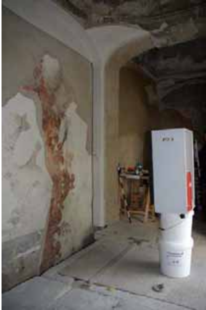
Abb. 7 Görlitz, Nikolaifriedhof, Wandmalerei in der Jakobigruft mit Erwärmung durch Gasstrahler
