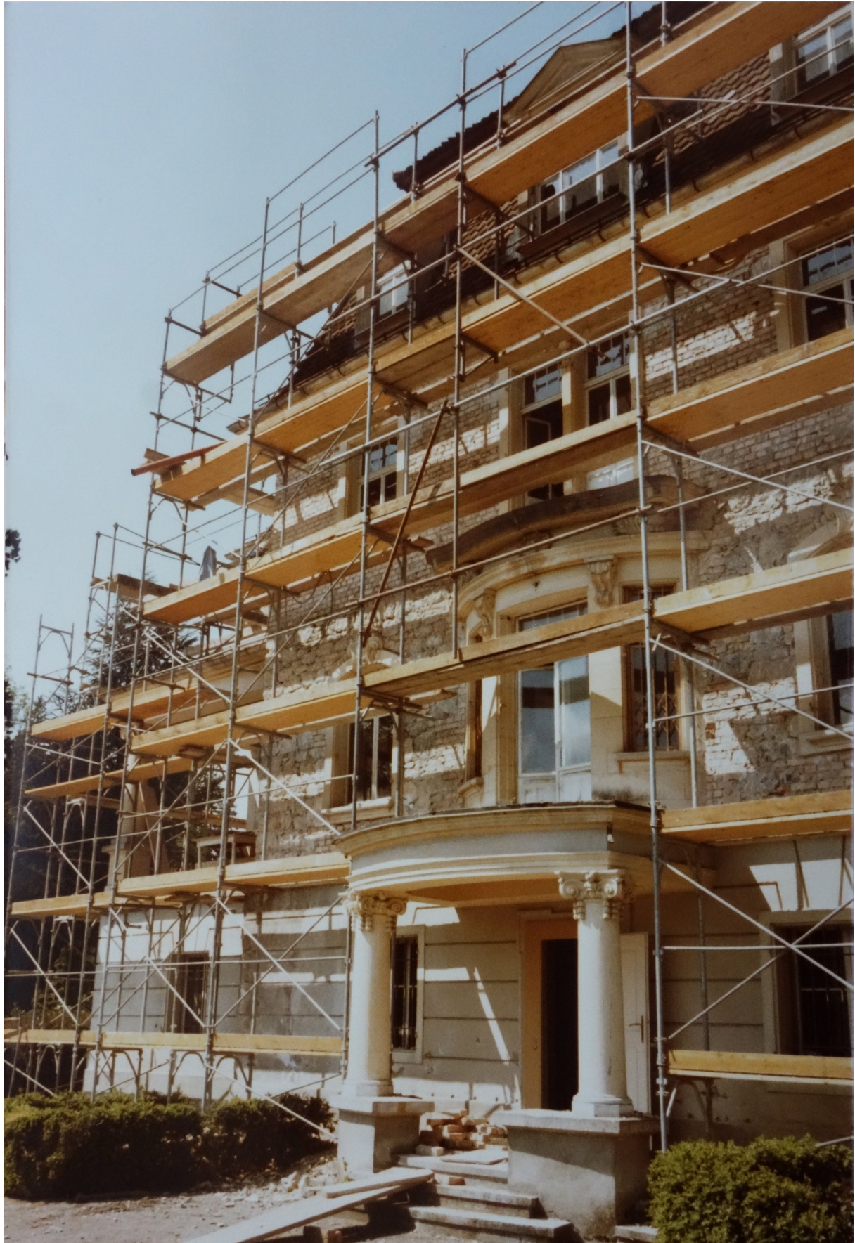
Aus der späten Bauphase von Villa und Gärtnerhaus gibt es ein paar spezielle Fotos.
