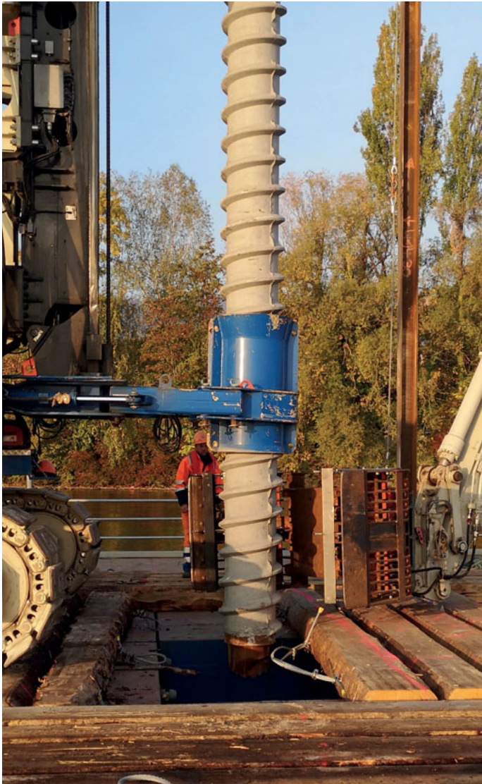
Positionierung Schraubpfahl auf dem Wasser per GPS, Probepfählung ZüriBahn. Foto EBP Schweiz AG, Zürich
