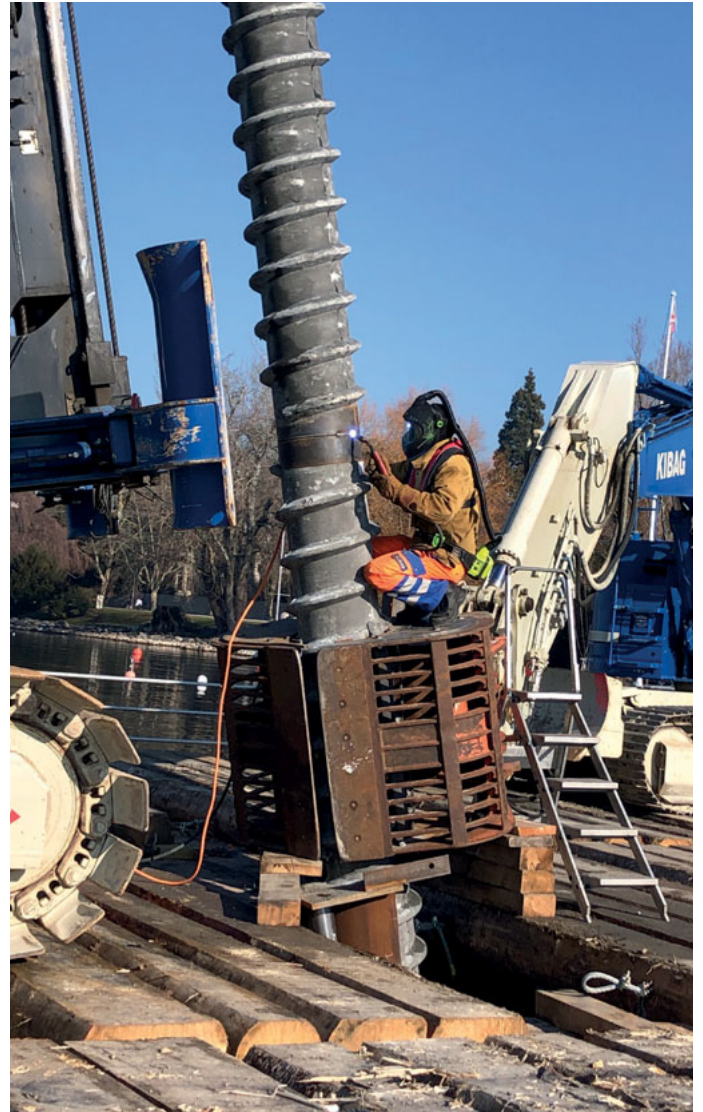
Schraubpfahl mit Neigung, Probepfählung ZüriBahn. Foto: EBP Schweiz AG, Zürich
