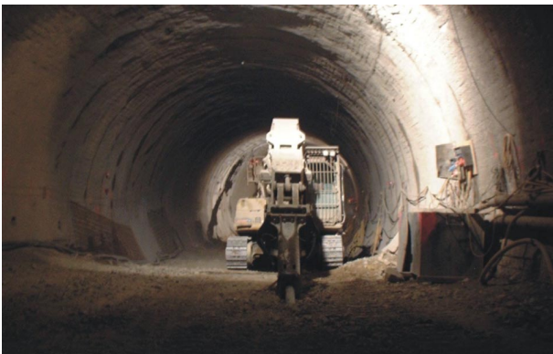
Bild 3: Kalottenvortrieb mit Hydraulikbagger
