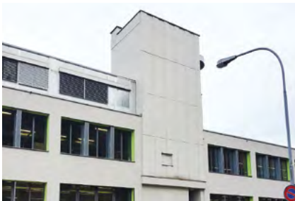
Der Silo ist im Gebäude integriert.
