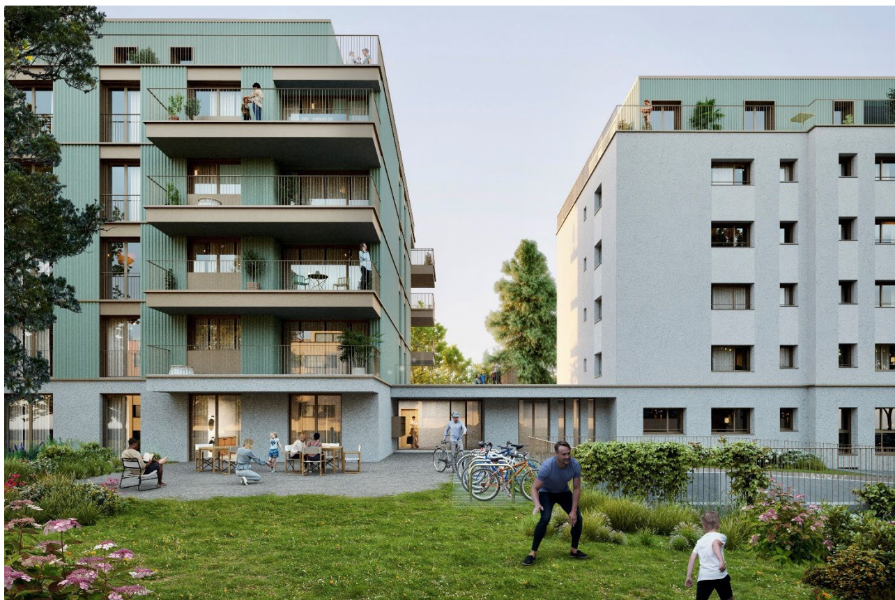
Neubau- und Renovations-/Aufstockungsprojekt an der Route du Bois 8, Ecublens (VD)
