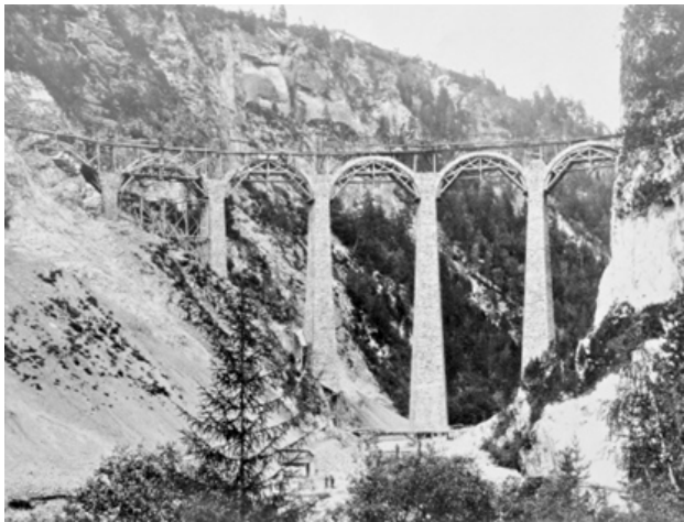
Abb. 5: Landwasserviadukt im Bau, um 1900 [6]
