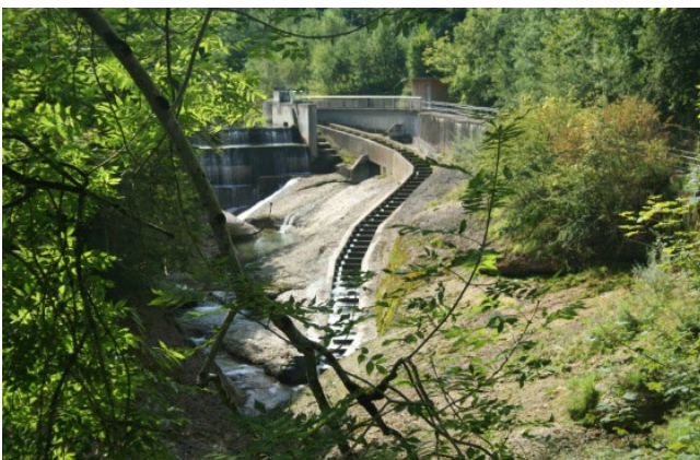
Abb. 15: Fischtreppe des Kraftwerks Soor (Baujahr 2001/2002) [32]
