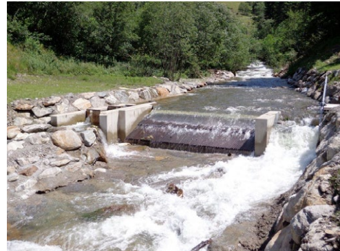
Abbildung 2-5 Tirolerwehr mit Fischaufstieg (rechtsufrig) und Spülschütz (linksufrig), [6]
