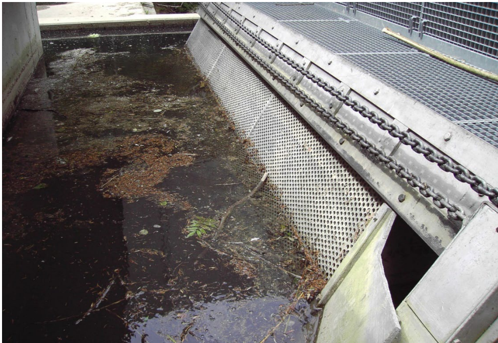
Abbildung 2-11 Lochblechrechen mit kettengetriebenem Horizontalreinger
