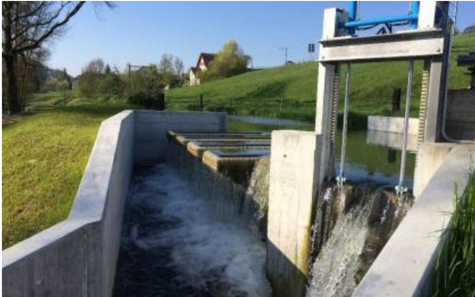
Abbildung 2-15 Oberwasserbecken mit Klaviertastenwehr als Entlastungswehr
