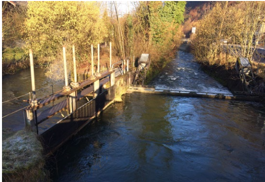
Abbildung 2-4 Seitenentnahme (links) mit beweglichem Segmentwehr
