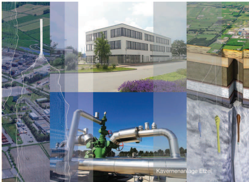
■ Abb. 2.5 Speicherstandort Etsel südwestlich von Wilhelmshafen mit 23 Rohölkavernen und 39 Gaskavernen als größter deutscher Speicherstandort für strategische Öl- und Gasreserven. (Quelle: IVG Caverns GmbH)
