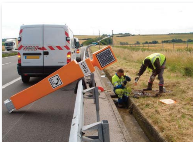
Servicearbeiten auf der Autobahn
