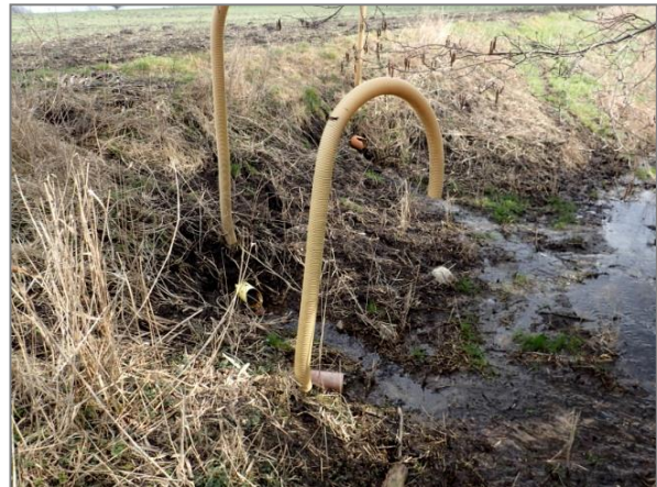
Abbildung 4-9: Drainageeinleitungen
