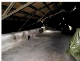
Oberste Geschoßdecke vor (links) und nach (rechts) einer Sanierung (Aufbringung einer begehbaren Wärmedämmung)
