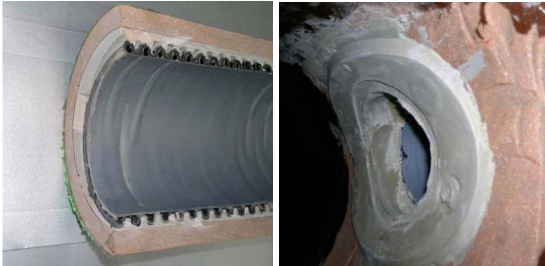
Bild 7: Verfüllung des Ringraums (rechts), sanierter Anschlussstutzen (links)
