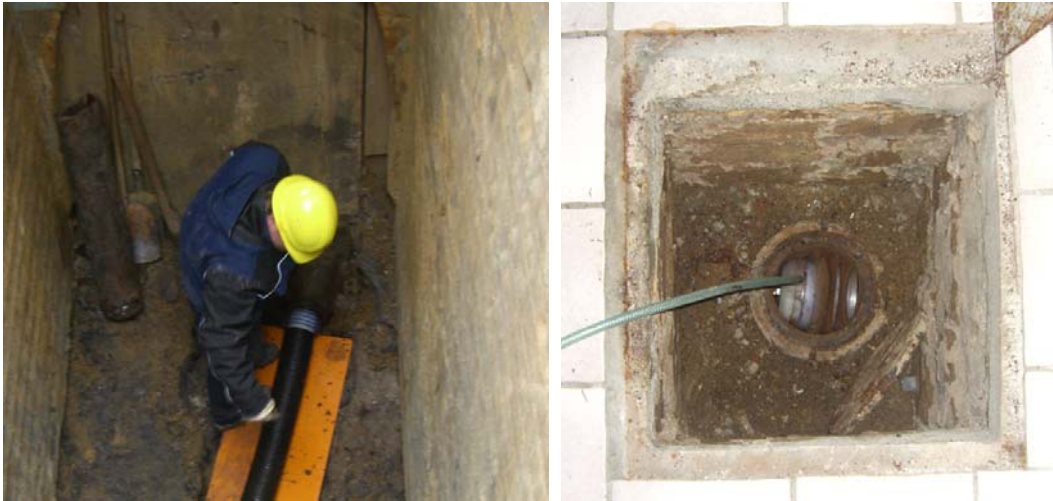
Bild 9: Startbaugrube am Kanal (links), Revisionschacht im Gebäude (rechts)
