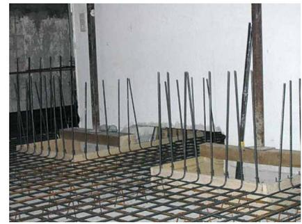
Abb. 12: Unterfangung der tragenden Innenwände des ersten Betonierabschnittes
