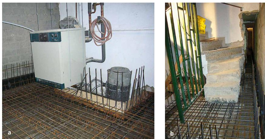
Abb. 10: An der Decke abgehängte haustechnische Anlage (a) und teillrückgebaute Kellertreppe (b)
