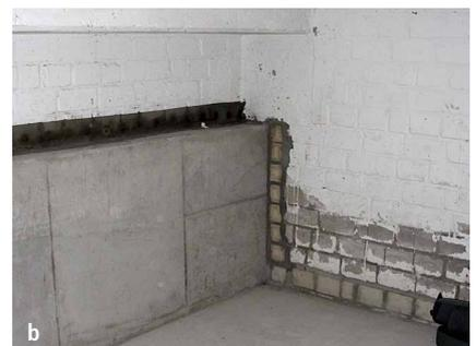
Abb. 17: WU-Wandkonstruktion (a) und Anschluss der Innenwände (b)
