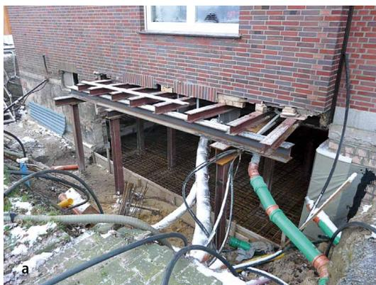
Abb. 21: Gebäude mit rückgebauter erster Hälfte des Mauerwerkskellers (a) und Bewehrung der neuen WU-Wandkonstruktion (b)
