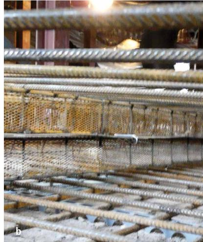
Abb. 24: Abdichtung der Arbeitsfuge zwischen Bodenplatte und Wand (a) sowie in der Bodenplatte (b). Zu sehen ist die Streckmetallabschalung der Bodenplatte mit integriertem beschichtetem Fugenblech (b).
