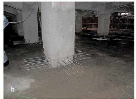
Abb. 15: Anschlusseisen an einem nicht unterbaubaren Pfeiler (a) und Abdichtung der Arbeitsfuge zwischen Pfeiler und neuer Bodenplatte mit einem Injektionsschlauchsystem (b)
