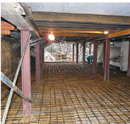
Abb. 20: Abfangung des Gebäudes durch einen Trägerrost auf Stahlstützen
