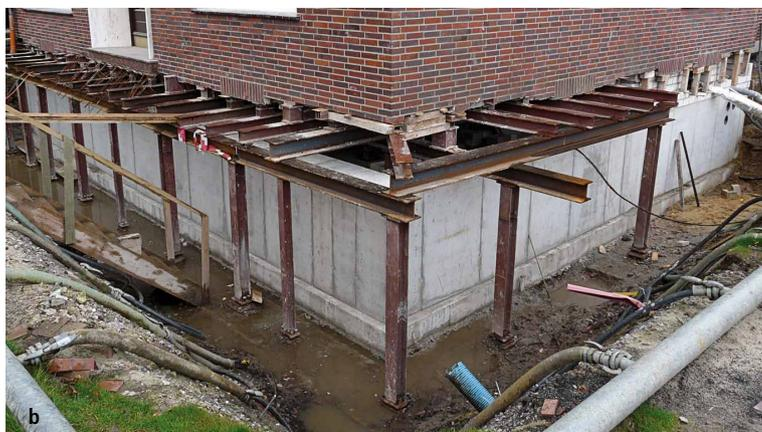
Abb. 23: Gebäude mit rückgebauter zweiter Hälfte des Mauerwerkskellers und der vorhandenen Bodenplatte (a) und nach Fertigstellung der weißen Wanne (b)
