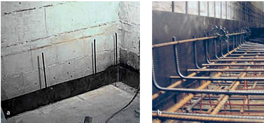
Abb. 5: Fugenabdichtung durch ein hälftig in eine Nut in der Bodenplatte mit Epoxidharz eingeklebtes, 25 cm hohes, unbeschichtetes Fugenblech (a) bzw. unbeschichtetes Fugenblech in der Arbeitsfuge zwischen Bodenplatte und Wand bei Einbau einer neuen Bodenplatte (b)
