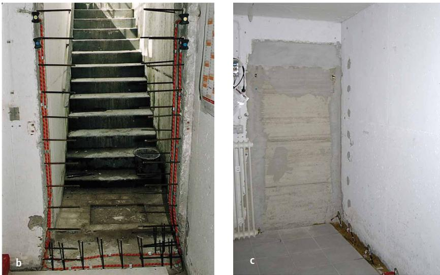
Abb. 11: Verschließen von Öffnungen/Verfüllen von Hohlräumen (b: Bewehrungsanschluss für den Verschluss der Kelleraußentür durch eine WU-Konstruktion und Injektionsschlauchsystem zur Abdichtung der Arbeitsfuge; c: durch eine WU-Konstruktion verschlossene Kelleraußentür)
