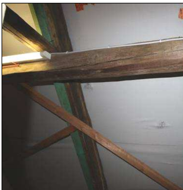
Abb. 47 und 48: Risse durch mechanische Überbeanspruchung
