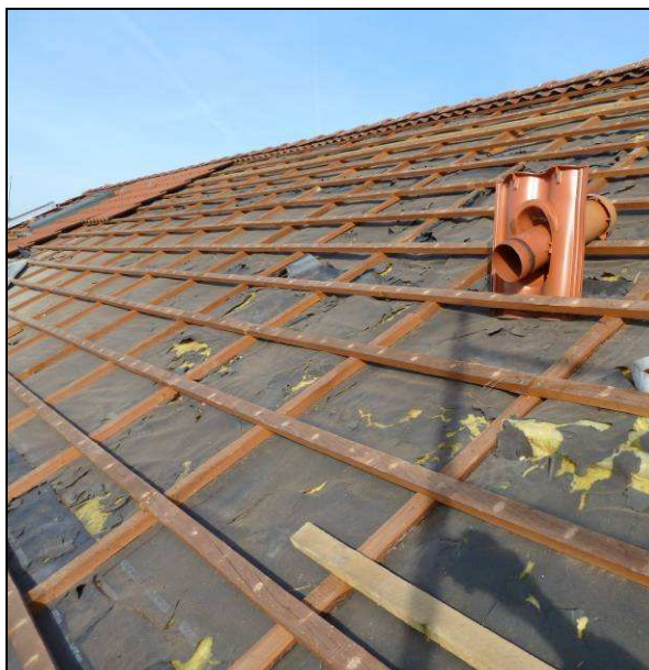
Abb. 43 und 44: Blick auf die zerstörte Unterspannbahn
