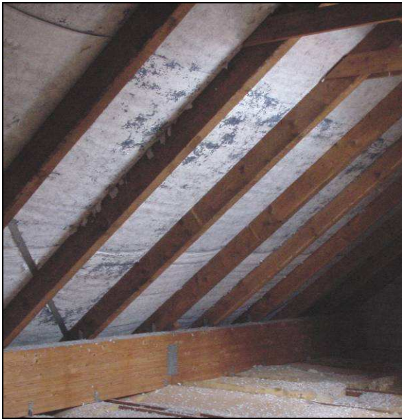
Abb. 37 und 38: Auflösen der unteren Beschichtung
