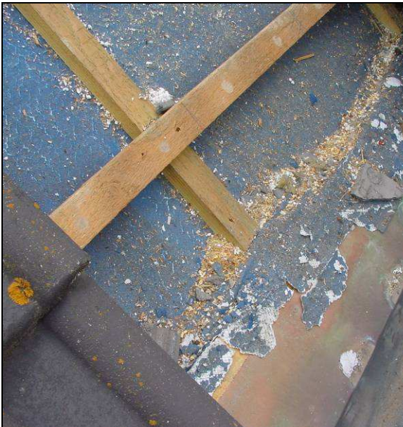
Abb. 31 und 32: Vollständige Zerstörung der Unterspanbahn in der Dachfläche und entlang der Traufe
