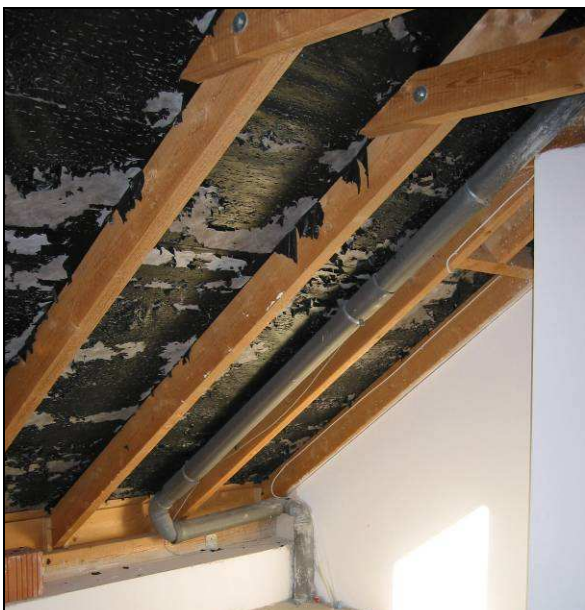
Abb. 39 und 40: Auflösen der unteren Beschichtung
