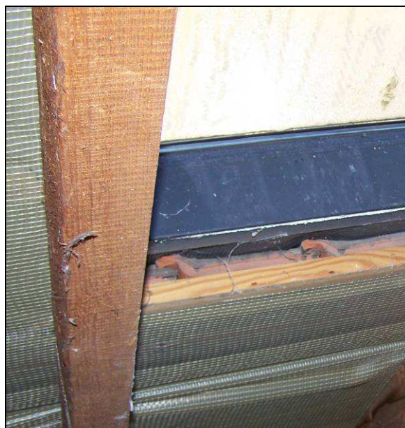
Abb. 58: Nach 28 Jahren voll funktionsfähige gitterverstärkte Folie trotz widriger Einbausituation
