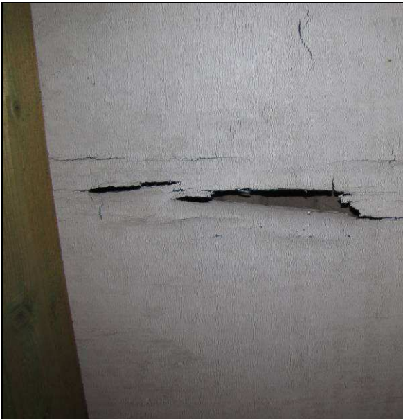
Abb. 35 und 36: Risse und Löcher in der Unterspannbahn in Feldmitte und am Rand der Sparrenfelder
