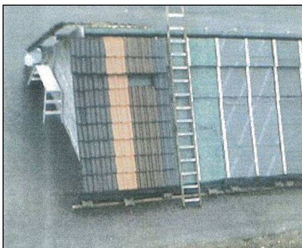
Abb. 22: Luftbild der Versuchsanlage
