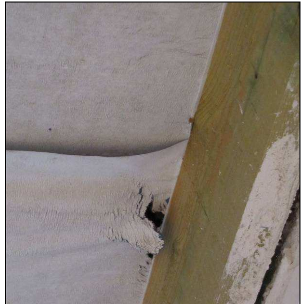
Abb. 35 und 36: Risse und Löcher in der Unterspannbahn in Feldmitte und am Rand der Sparrenfelder
