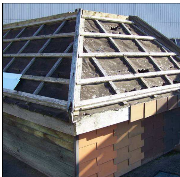
Abb. 21: Ansicht eines L-förmigen Versuchshäuschens, das mit einer V13-Bahn eingedeckt wurde.
