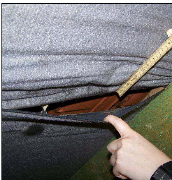
Abb. 55: Unterspannbahn ohne Schäden...
