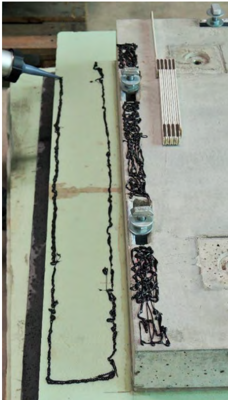
Abbildung 62: Aufbringen des Dichtstoffes (links); Aufgesetztes Wandbauteil (rechts)
