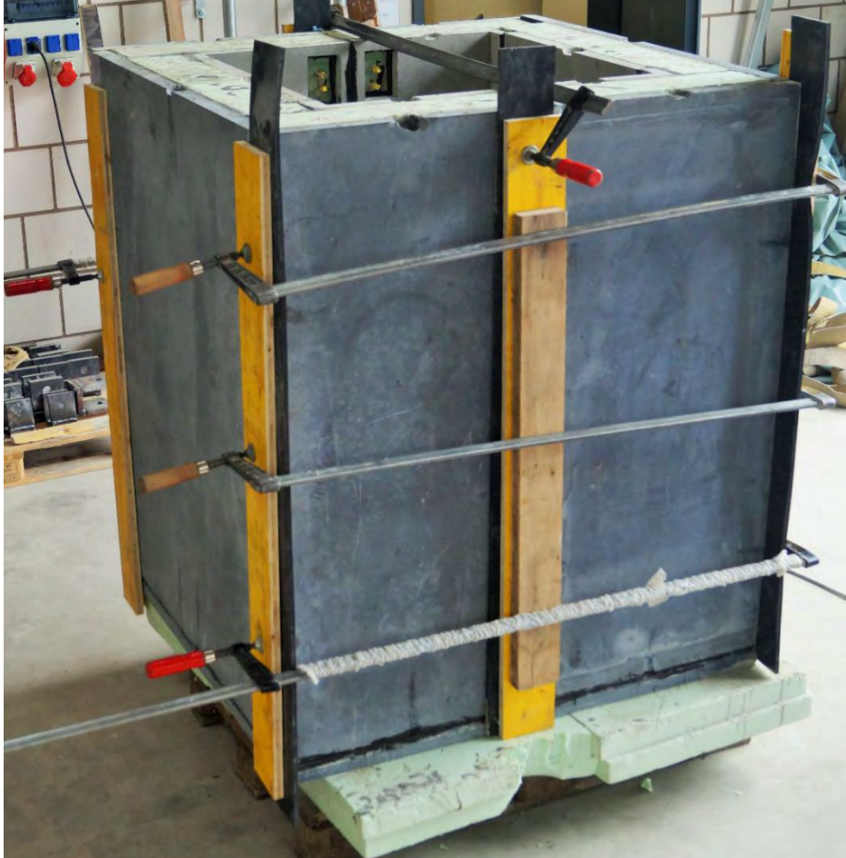
Abbildung 64: Schalung zum Verfüllen der äußeren Fugen
