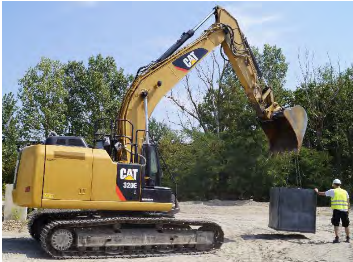
Abbildung 68: Transport mit dem Bagger
