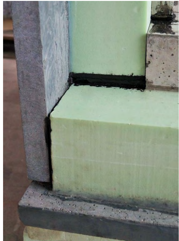
Abbildung 62: Aufbringen des Dichtstoffes (links); Aufgesetztes Wandbauteil (rechts)
