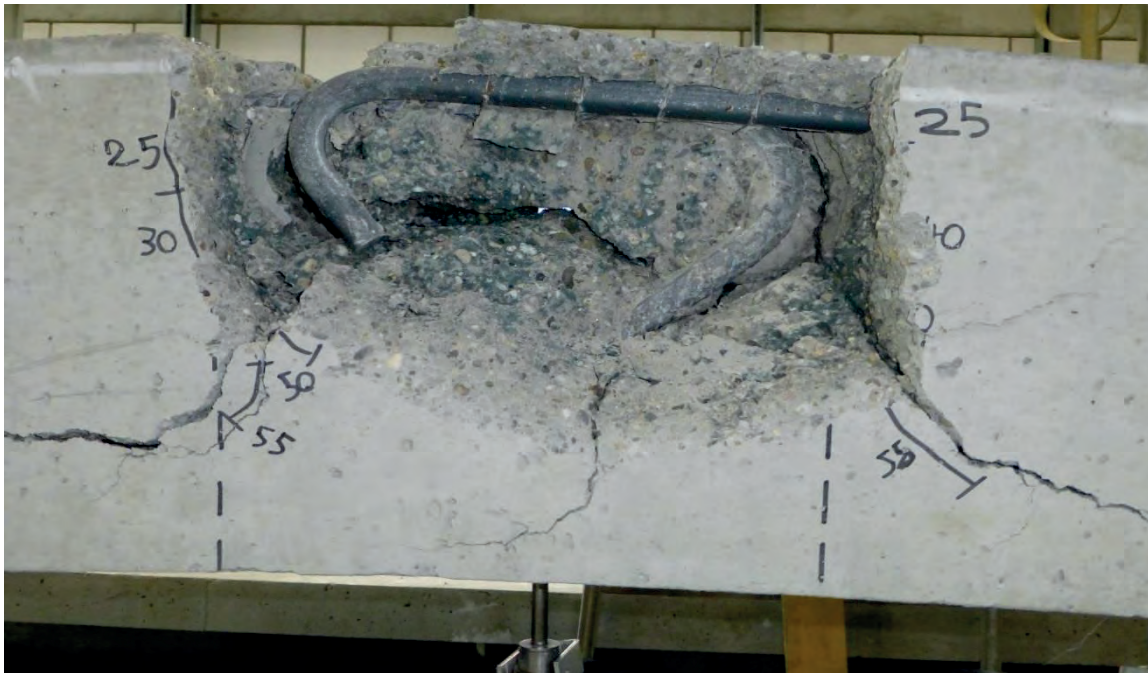
Bild 4.17: Seitenansicht Balken mit Stoß Typ II und muschelförmigem Betonausbruch
