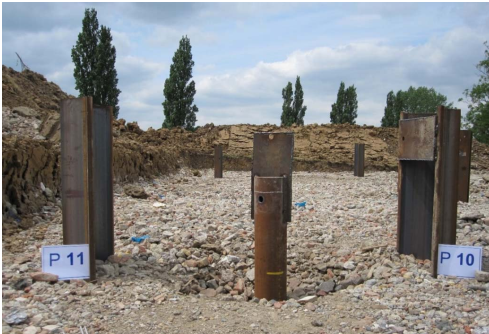
Abbildung 11: Versuchsaufbau im Feld mit eingebetteten Spundwandprofilen
