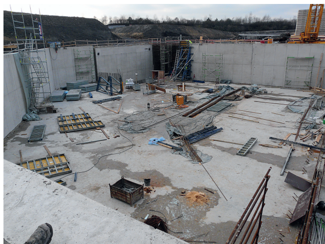
Abb. 1: Wasserundurchlässiges Bauwerk aus Beton
