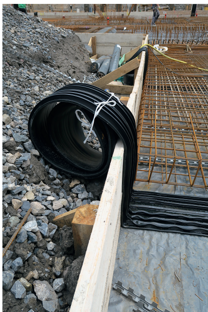
Abb. 5: Unbeschichtetes Fugenblech in der Arbeitsfuge zwischen Bodenplatte und Wand mit einer Betonaufkantung
