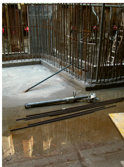
Abb. 5: Unbeschichtetes Fugenblech in der Arbeitsfuge zwischen Bodenplatte und Wand mit einer Betonaufkantung
