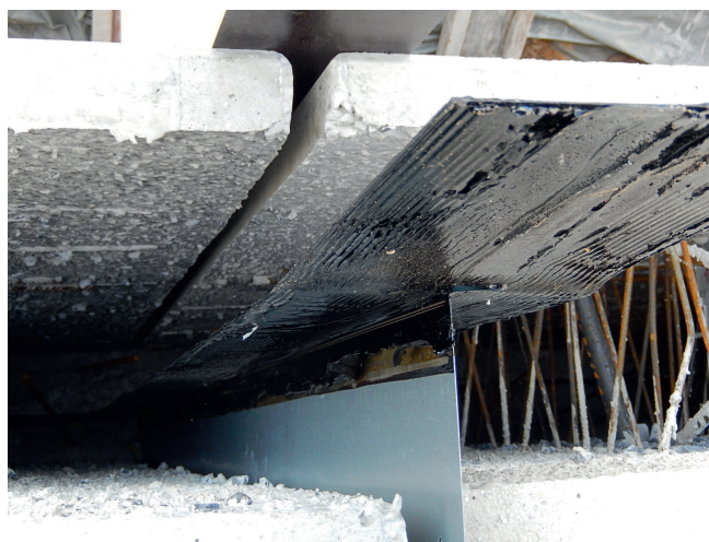
Abb. 16: Beispiel einer Sollrissfugenschiene
