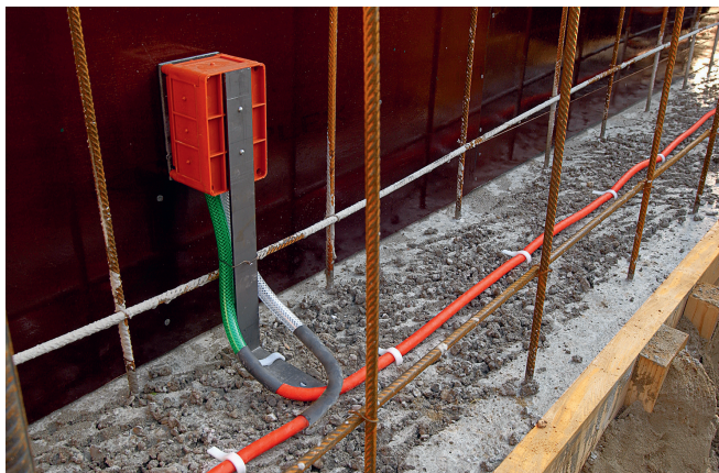
Abb. 10: Injektionsschlauchsystem in einer Arbeitsfuge
