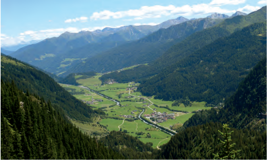
Abb. 5 - Übersichtsfoto auf den Talboden des mittleren Ridnauntals von der Straße zur Aglsalm aus aufgenommen. Man beachte, dass der Ridnauner Bach zum Großteil verbaut und begradigt wurde. In der Bildmitte bzw. leicht links liegt der Hügel mit der Kirche St. Magdalena; es handelt sich um alte Bergsturzmassen, die einst das Tal versperrten und einen See aufstauten. Im Hintergrund der Grenzkamm zum Eisacktal.
