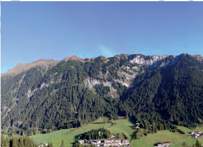
Abb. 125 - Übersicht auf den linken Hang des Ratschingstals bei Pichl: (1) und (2) bezeichnen die Hauptaufschlüsse einer alten Massenbewegung vom bergseitig liegenden Hang, der fast vollständig durch Murschuttströme zweier großer, miteinander verschmolzener Kegel (Wiesenflächen) bedeckt ist. Das Foto wurde vom gegenüberliegenden Hang, im Bereich von Blosegg, aufgenommen.
