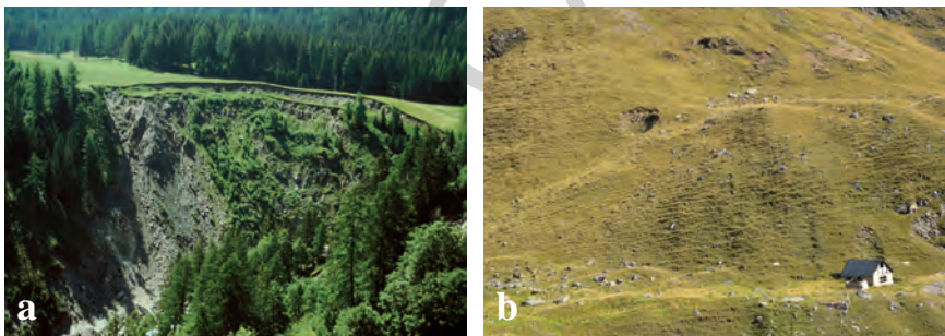
Abb. 177 - a) Rotationsrutschung in glazialen Ablagerungen auf der rechten Seite des Pfelderer Baches gegenüber der Zagl Höfe (Pfelderer Tal). Fotoarchiv der Agentur für Bevölkerungsschutz - Autonome Provinz Bozen; b) Sinkhole westlich der Unterer Moarerbergalm und rechts davon flachgründige Rutschungen in glazialen Ablagerungen (Lazzacher Tal).
