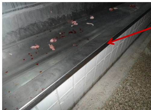
Abbildung 100: Podestkante, während der Produktion (Schlachtbetrieb)
