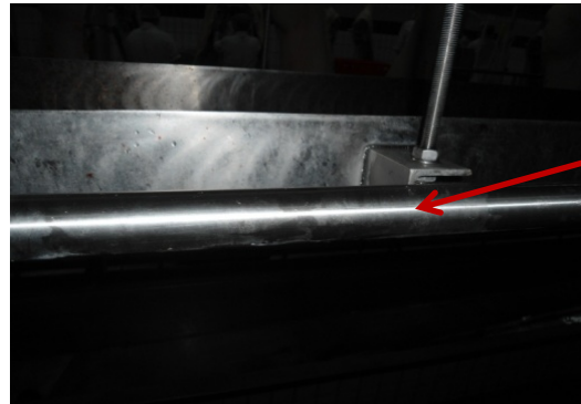
Abbildung 102: Geländer, während der Produktion (Schlachtbetrieb)
