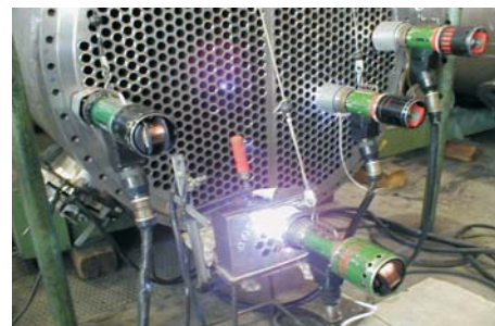
Orbital Titaneinschweißung von Rohren in einer Rohrplatte
