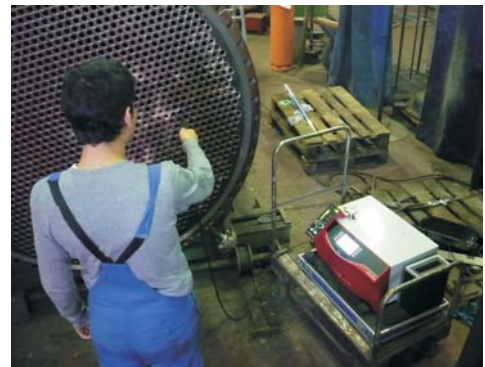
Helium Lecksuche an einem Wärmeaustauscher mit eingeschweißten Heizflächenrohren in der Rohrplatte.
