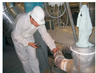
Wanddickenmessung an einer Rohrleitung mit Ultraschall
