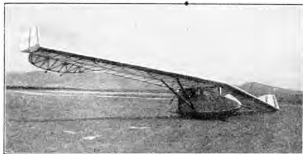
Abb. 7. Der „Motor-Storch“ von Alexander Lippisch als Segelflugzeug mit 9 PS-DKW-Motor
