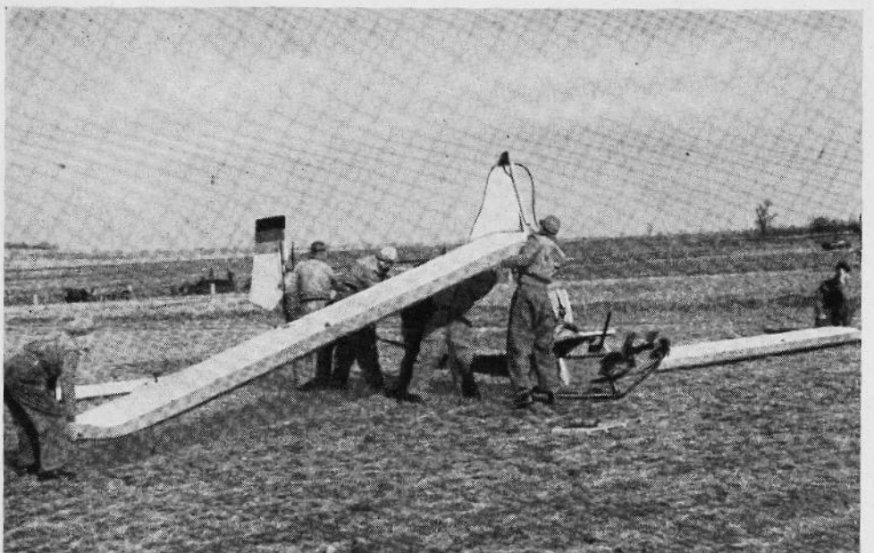
Bild 132 So werden die Tragflügel nacheinander eingehängt
