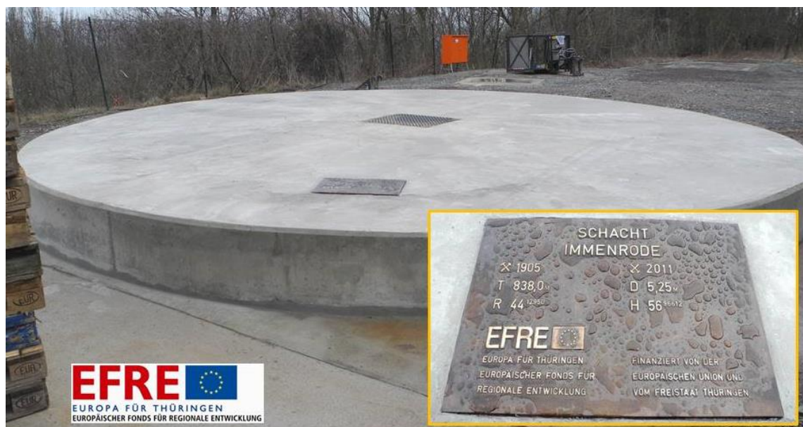
Abb.5 : Schachtdeckel des Schachtes Immenrode nach Beendigung der Verwehrmaßnahme im Jahre 2011.
