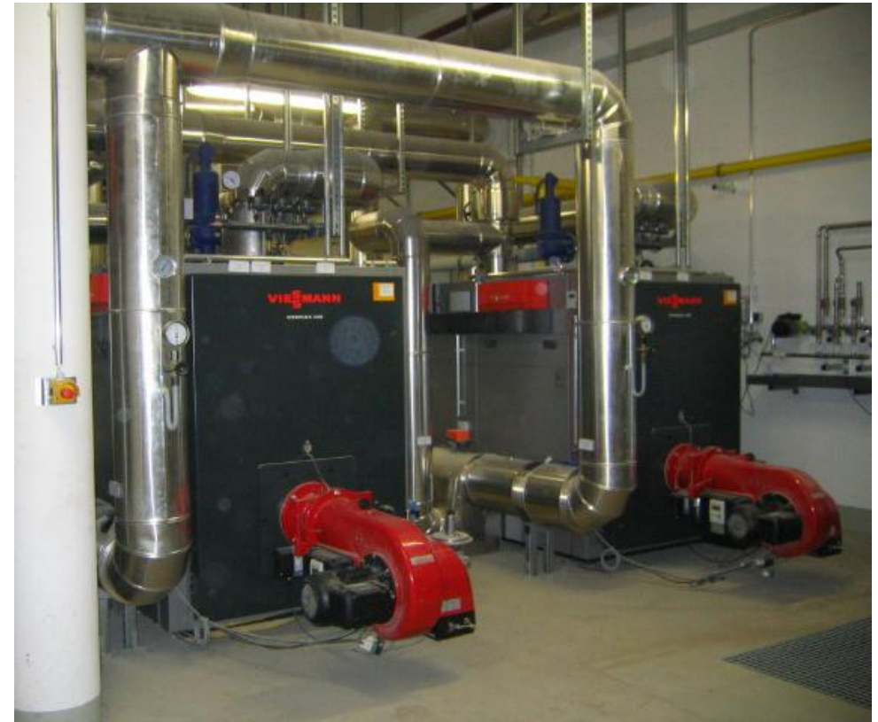
Biogas BHKW Hamburg Energie
