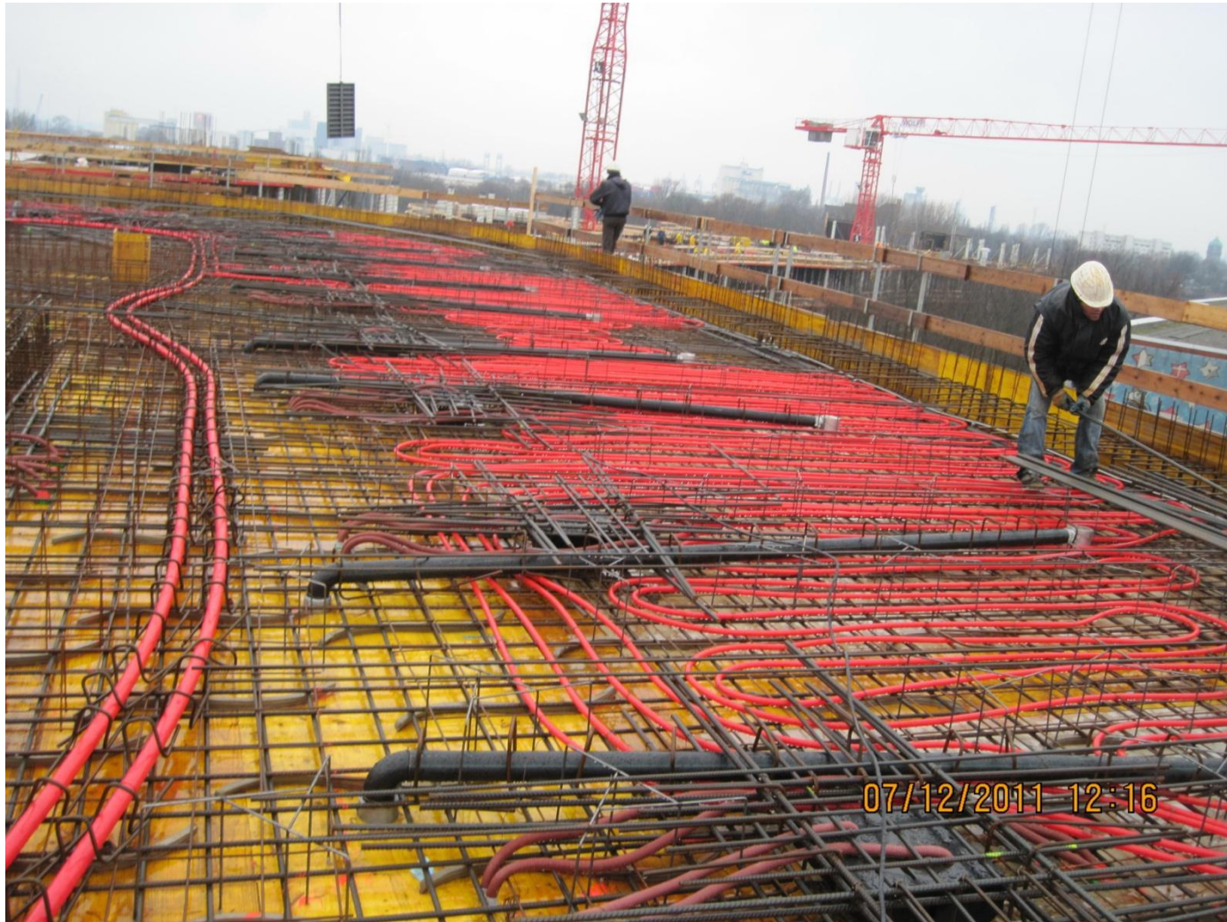
Bauausführung thermoaktive Decken Quelle: Obermeyer Planen+Beraten GmbH
