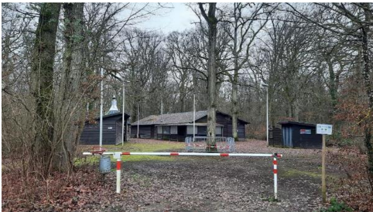
Abbildung 8: Südlicher Teilbereich mit bestehenden Räumlichkeiten aus Blickrichtung Süden. Quelle: Oeko-Bureau, 2021.
