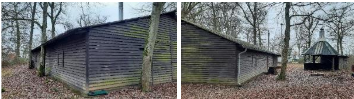
Abbildung 10: Links: Südwestlicher Rand des Plangebietes entlang des südlichen Gebäudes mit Hainbuchen (Blickrichtung Norden). Rechts: Südöstlicher Rand der Plangebietes (Blickrichtung Norden). Quelle: Oeko-Bureau, 2021.
