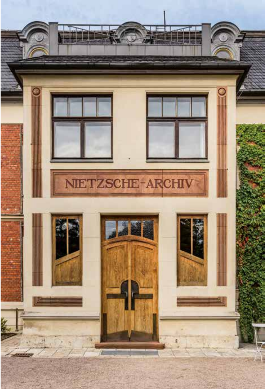
Tafel 7 (zu S. 75) Neuer Vorbau des Nietzsche-Archivs, Weimar, 1903 (Foto 2018)
