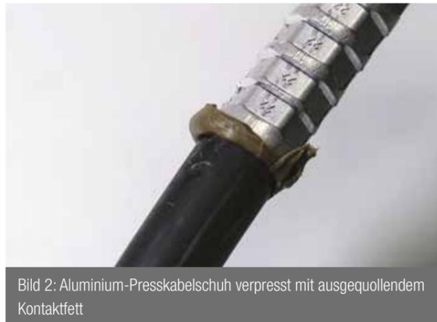
Bild 2: Aluminium-Presskabelschuh verpresst mit ausgequollendem Kontaktfett
