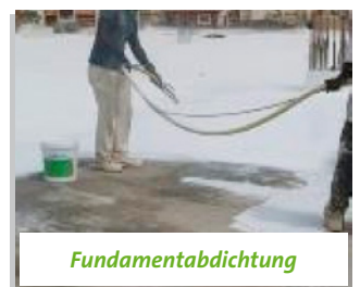
Abdichtung auf Bitumen
