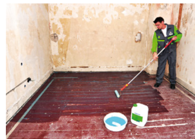
Grundierung einer Holzfläche mit KÖSTER VAP I 06 Primer
