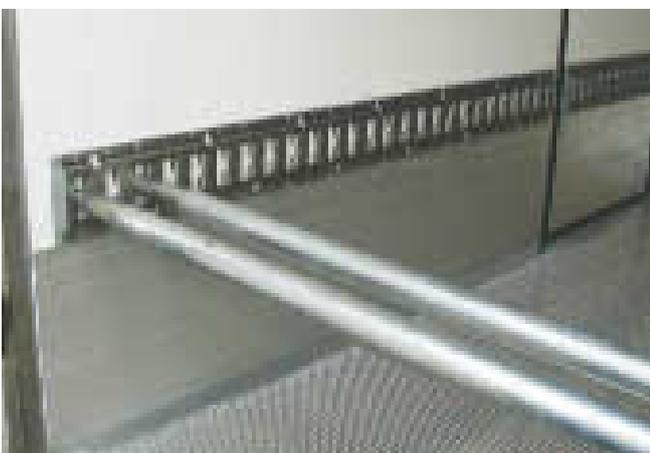
Ankerschiene mit Sperrstangen
