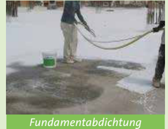
Abdichtung auf Bitumen
