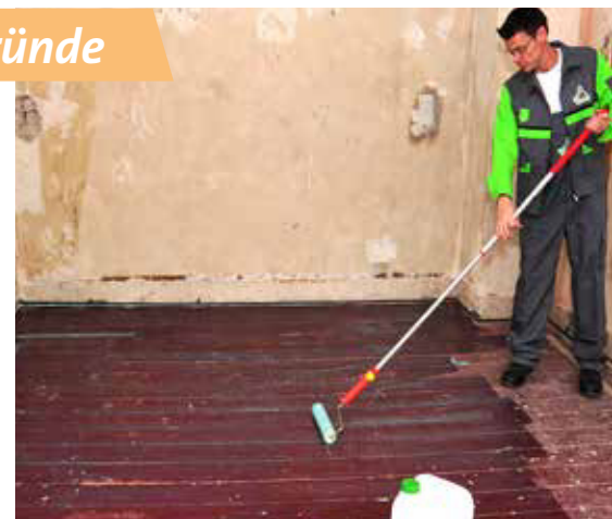
Grundierung einer Holzfläche mit KÖSTER VAP I 06 Primer
