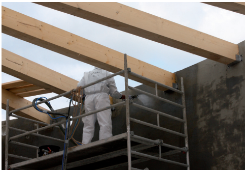
Aufbringen der Schutzbeschichtung
