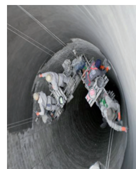
Die Betonschutzarbeiten
