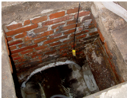
Der unbehandelte Schacht
