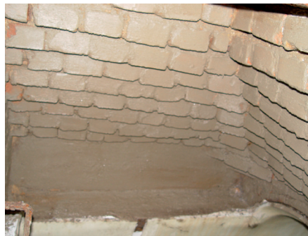
Füllen der Fugen und Beschichten der Ziegel
