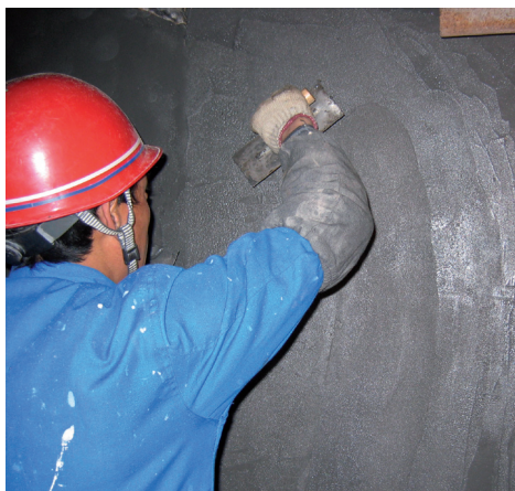
KÖSTER CMC wird in zwei Lagen verarbeitet und erreicht einen sehr guten Haftverbund mit Stahl
