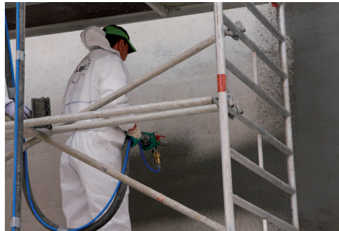
Aufbringen der kristallisierenden Beschichtung
