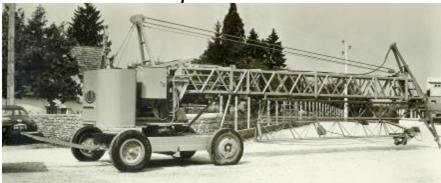
Zum Transport wird der Turm nach vorne umgelegt. Der Ausleger wird umgeklappt. Der Turm wird über ein Aufrichtebock (A Bock) mittels vielfacher Seileinscherung aufgezogen.
