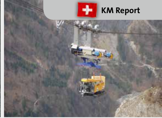
Transport Raupenkrane Liebherr LR 1160 mit der Schwerlastbahn von 800 auf 1800 m ü. M.
