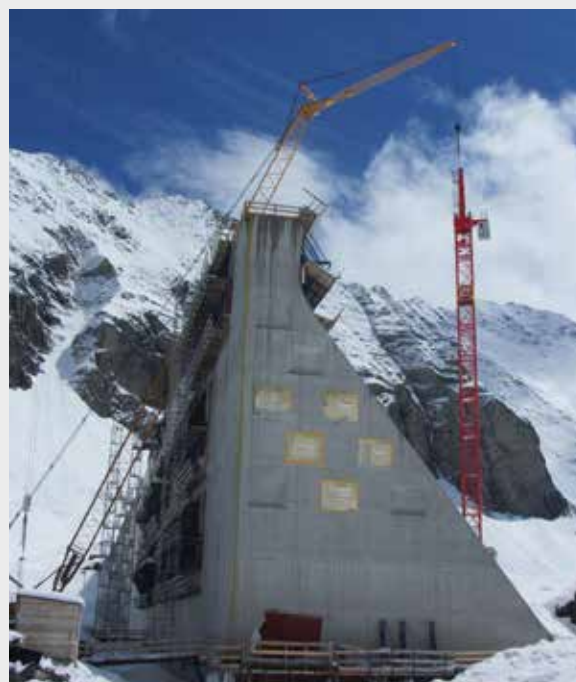
Kranmontage eines Wolff 6531.
