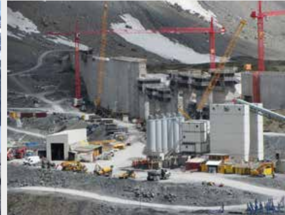
Staumauerbau wasserseitig in Richtung Osten mit Betonanlage und auf der linken Seite die Werkstatt.
