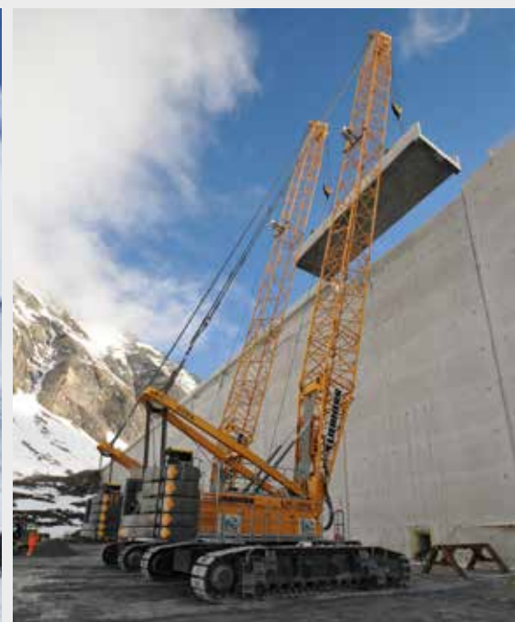
Tandemhub der vorgefertigten Brückenelemente mit zwei Liebherr Raupenkrane Typ LR 1160.
