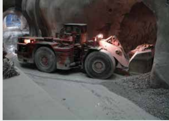
Radlader (Marke Torro, 7 m 3 -Schaufel, Deutz-Motor V12, luftgekühlt) beim Schottern der Trafokaverne.
