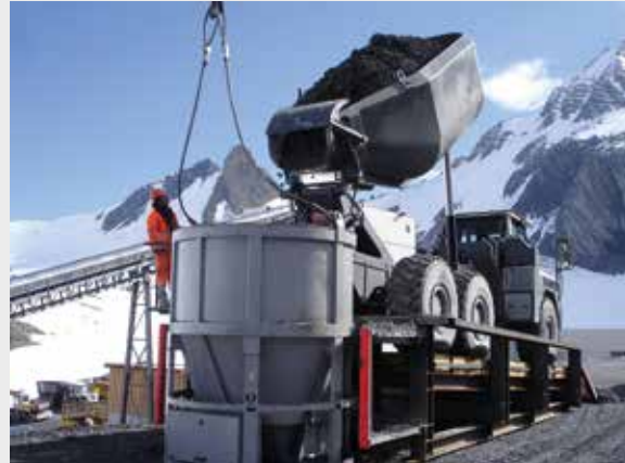
Liebherr Dumper beim Abladen des Staumauerbetons in einen 6 m 3 fassenden Krankübel.
