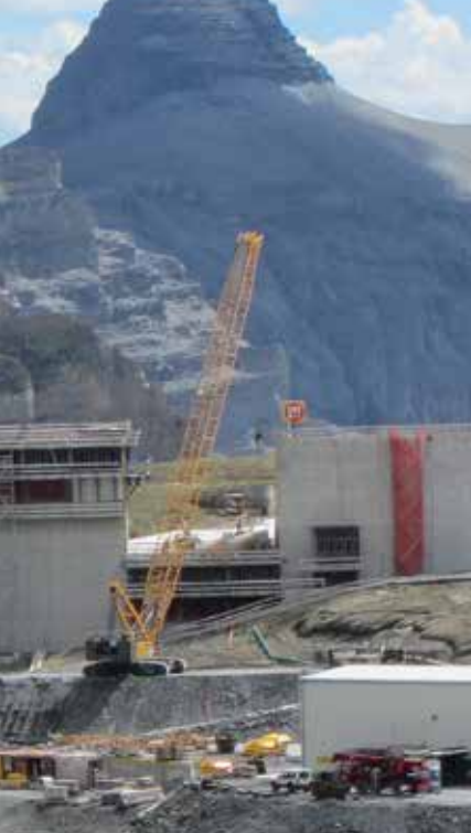
Liebherr Raupenkrane LR 1160 mit Kranführer Paul Janser. Der Raupenkrane erledigt seine Arbeit zuverlässig bei Sonne, Regen, Wind und Schneetreiben.
