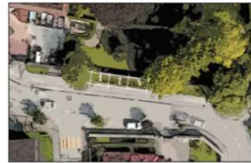
SUD DU MUR DU JARDIN BOTANIQUE, RUE THURMANN.
