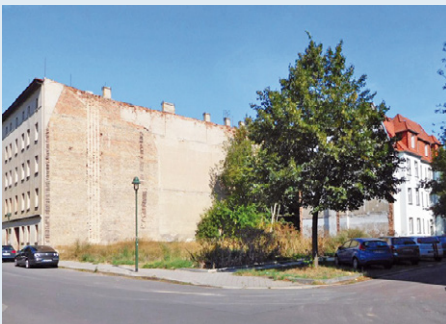
Vor und nach dem Abbruch des Eckgebäudes
