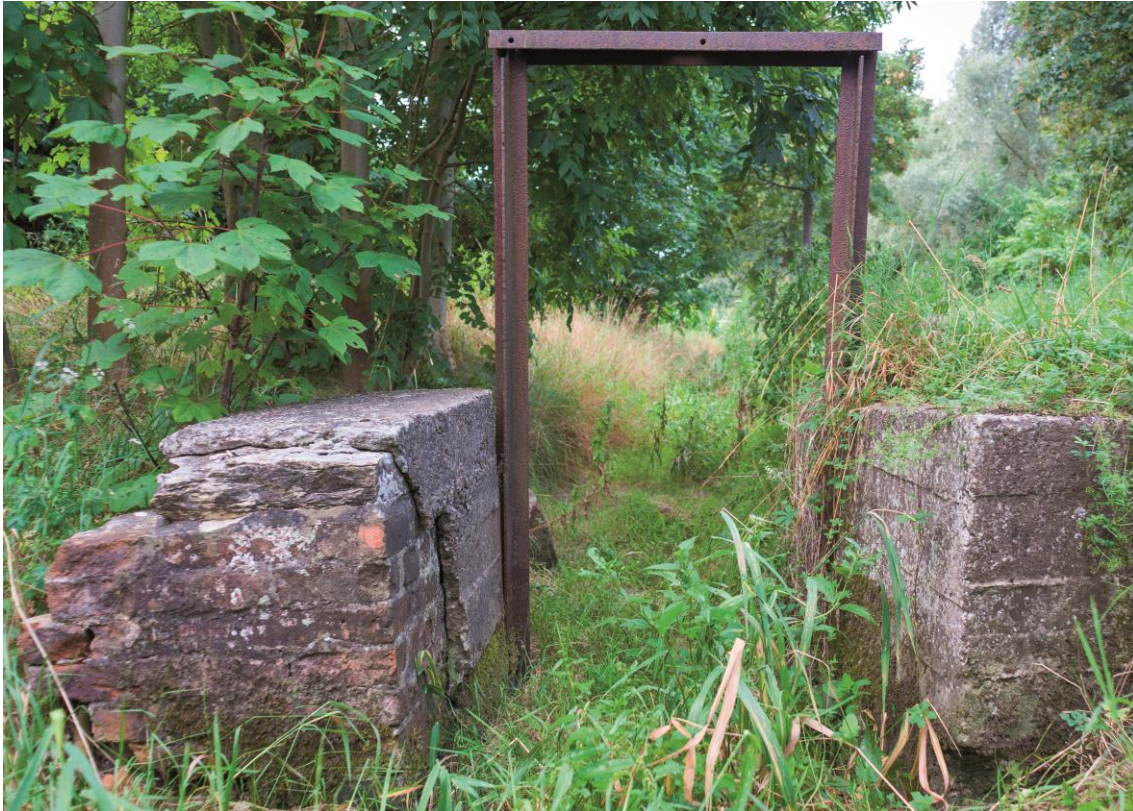
Abb. 3-3: Altes Wehr im Seskerbruch
