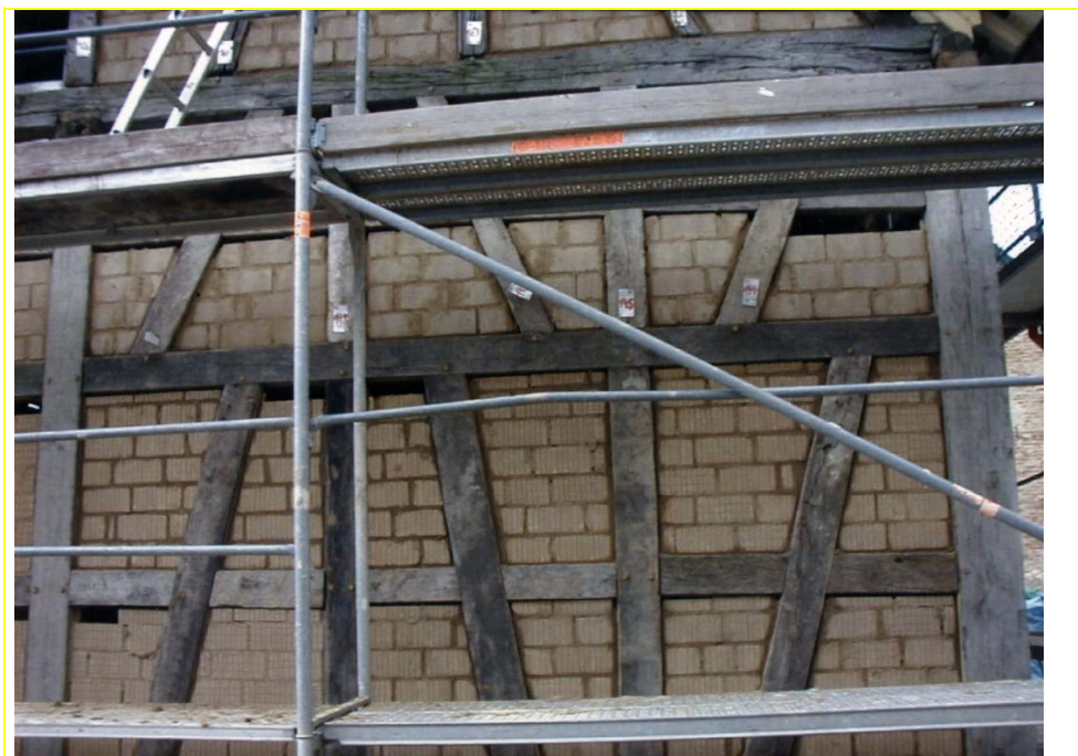
Abb. 8.1-06: Fachwerksmauerung mit Lehmsteinen (Kliebe, 2001)
