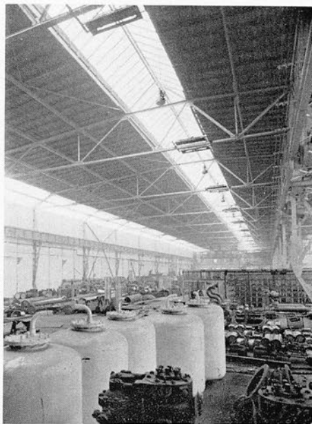
Infrarot-Strahler in der Maschinenfabrik Grasbrook
