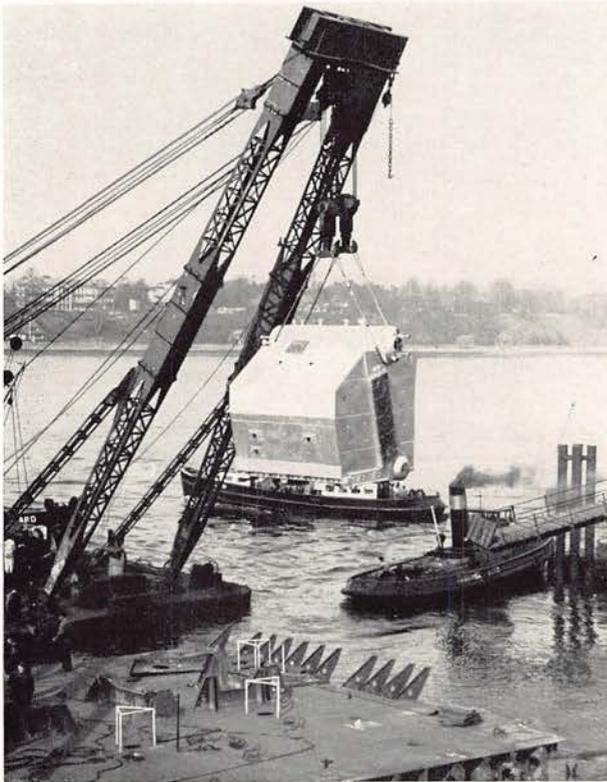
*Der Schwimmkran setzt einen Kessel auf das Doppelbodenteilstück (Kesselgewicht 85 t)*
