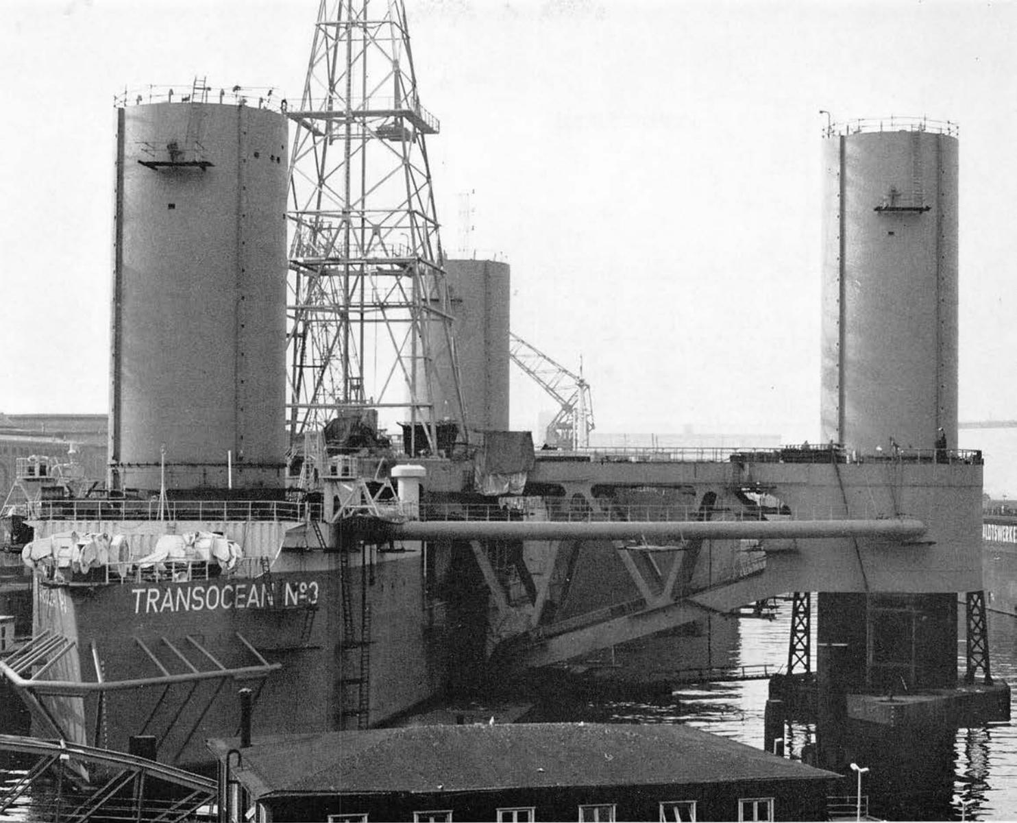
festgesetzt sind, werden sie gleichzeitig entballastet, und die Barge hebt sich aus dem Wasser auf Drilling Condition.
