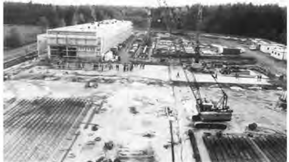
Der Bauplatz in Mitterteich
