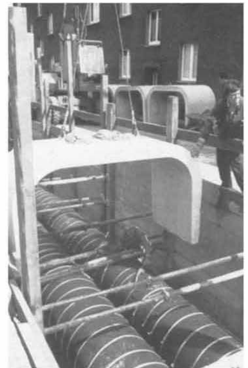
Foto: Verlegung von Fernwärmetrasse in Hauskanälen
