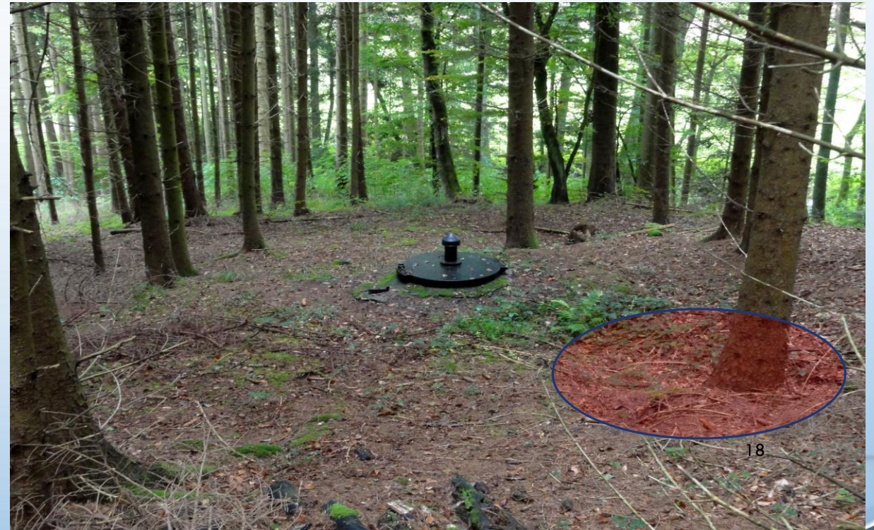
BEWUCHS ÜBER DER FASSUNG - IST
