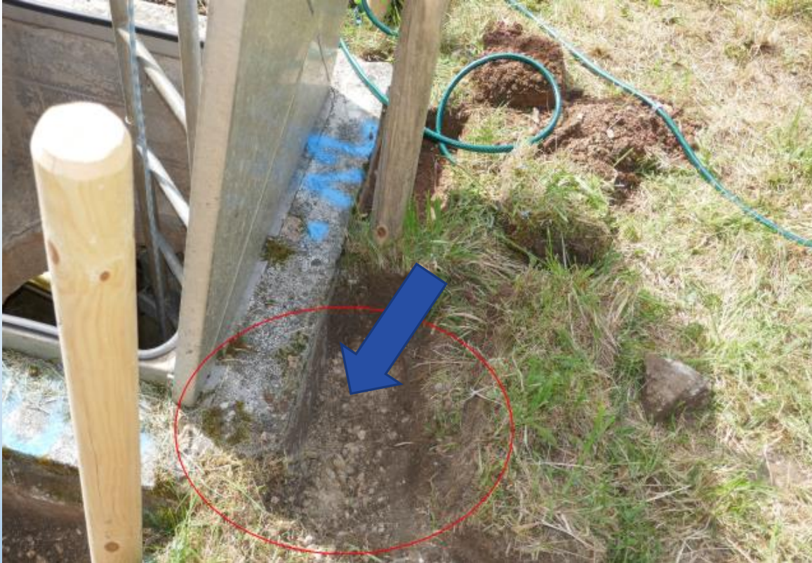
Kiesig-sandige Arbeitsraumverfüllung am Schacht
