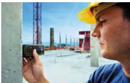
D5 - Vermessung im Außenbereich
