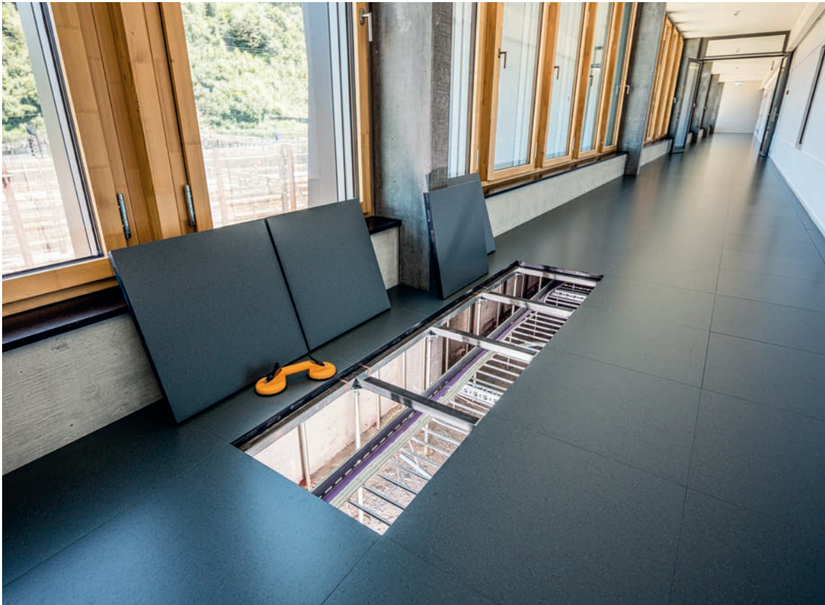
Bodenplatten mit Kautschukbelag auf hohen Stützen mit fix aufgeschraubten C-Profilen.
