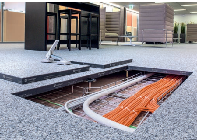
Bodenplatten mit fixem Bodenbelag sind untereinander ohne Verlust austauschbar.
