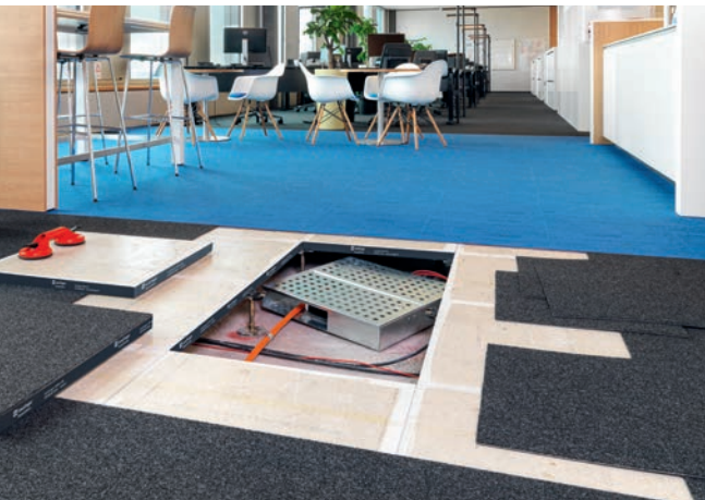
Die handelsüblichen Teppichplatten sind kleiner, weshalb die Fugen nicht übereinstimmen.
